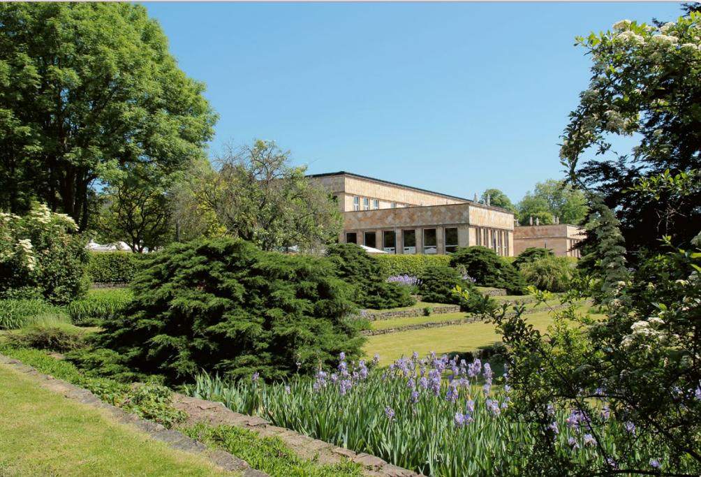
Campus Westend, Casino, Festsaal I im Erdgeschoss
